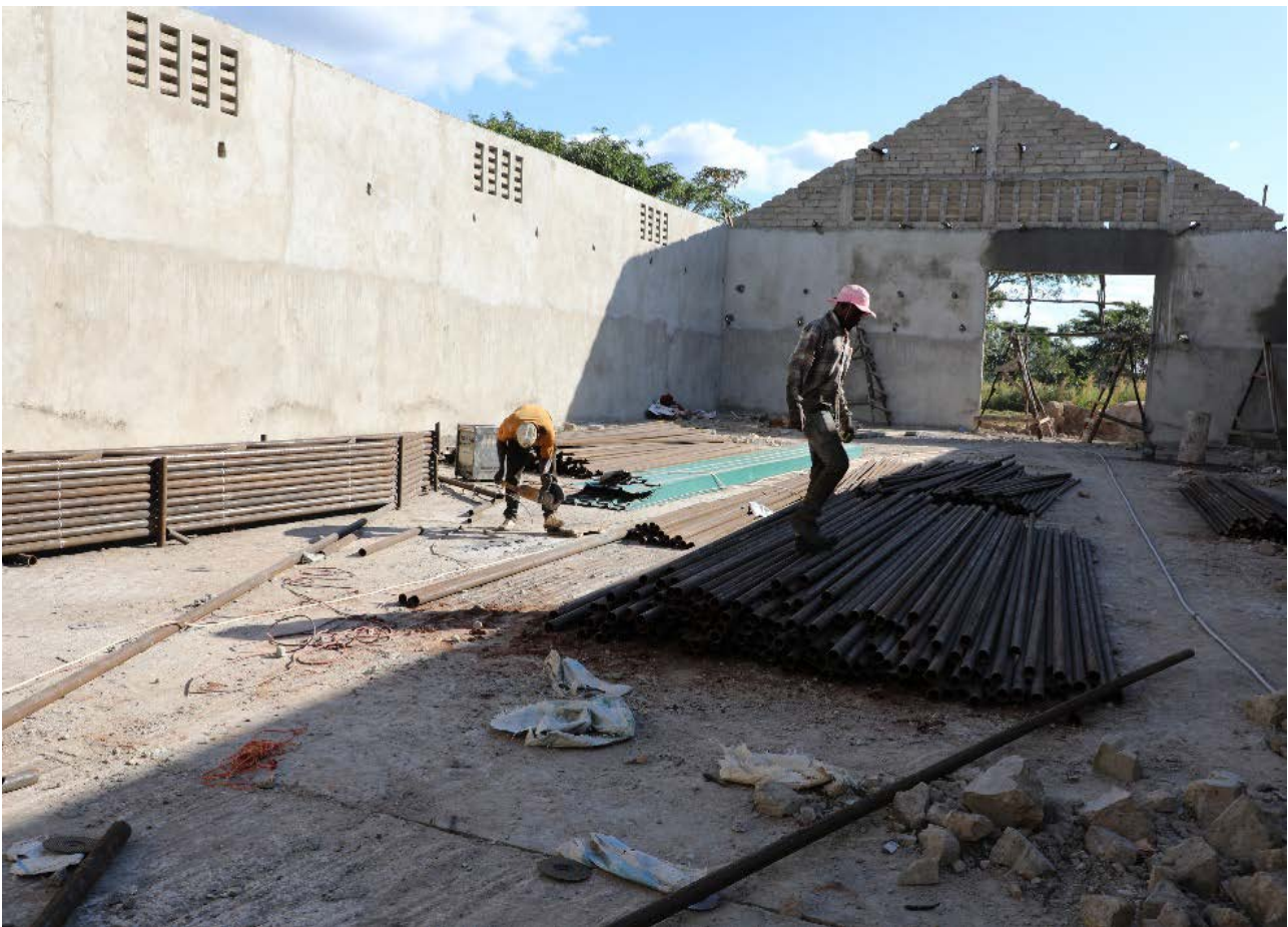
Wafanyakazi wakiwa katika hatua mbalimbali za ujenzi wa Kiwanda cha Vifungashio kinachojengwa na Chama Kikuu cha Ushirika cha (SONAMCU LTD) Mkoani Ruvuma
